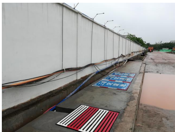
临时排水沟+沉沙池
